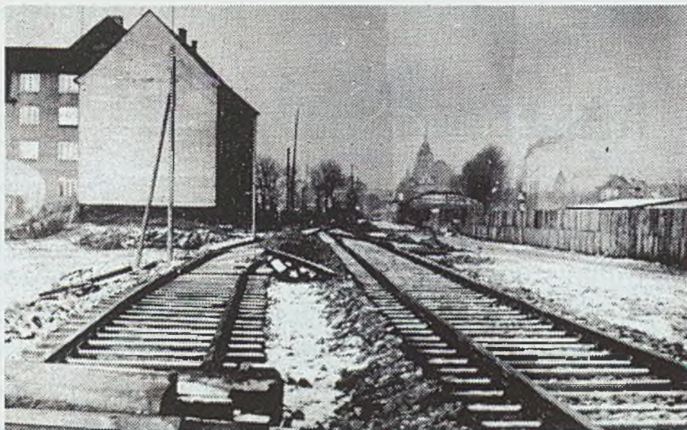
Bocznica kolejowa w rejonie dzisiejszego Wydziału Automatyki, Elektroniki i Informatyki
