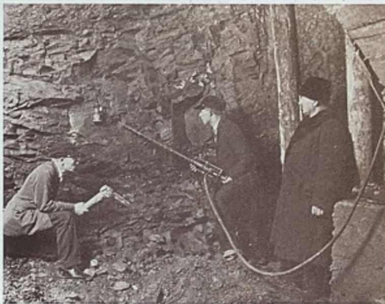
Poziomy drugi i trzeci powstały dopiero w latach 1958-1966. Były one budowane przez uczniów dla kolejnych pokoleń wychowanków szkoły
