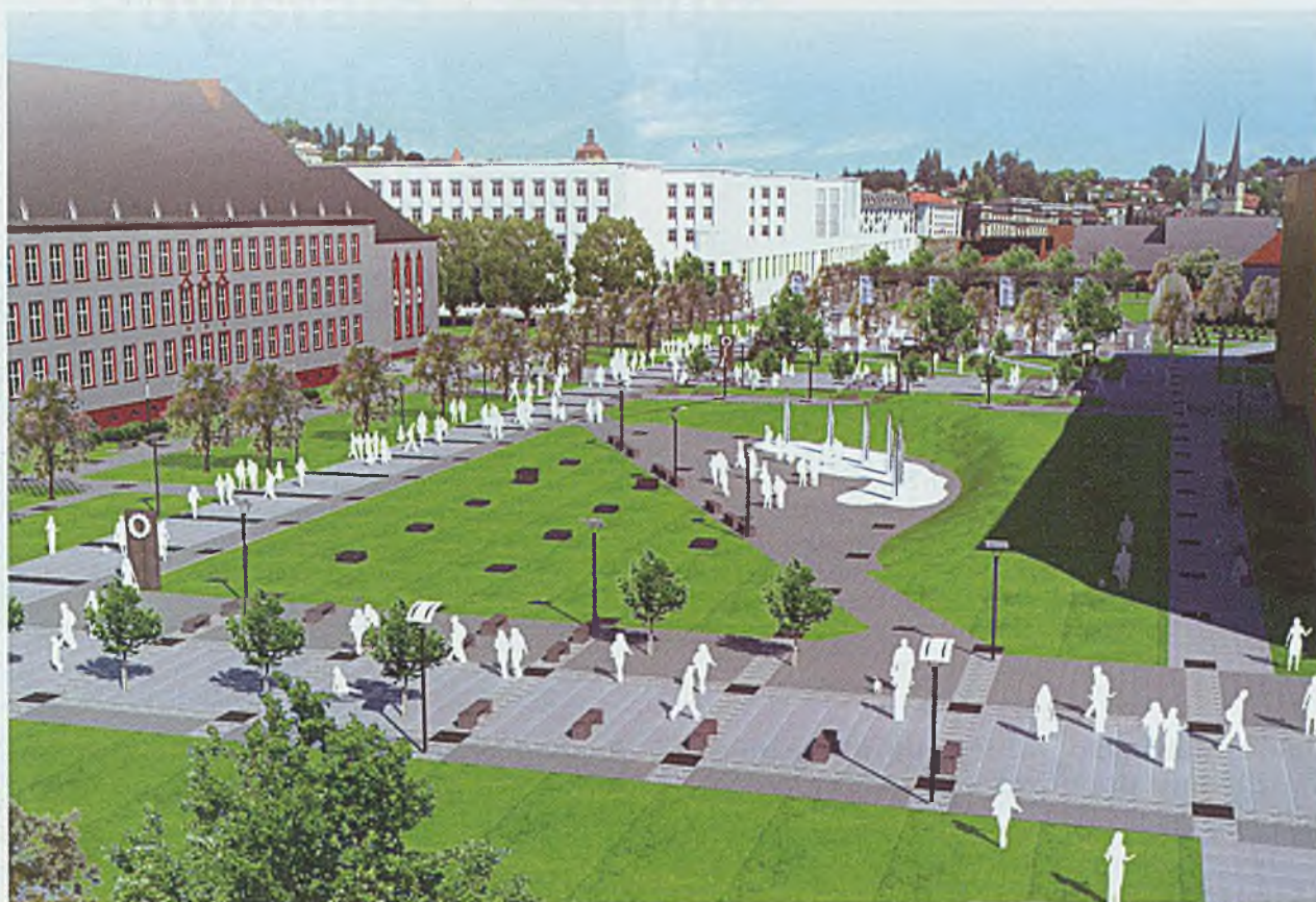
Powyżej ulica Akademicka na wizualizacji przedstawiającej koncepcję jej zagospodarowania autorstwa dr. inż. arch. Tomasza Bradeckiego. Poniżej ten sam teren w październiku 2014 roku
