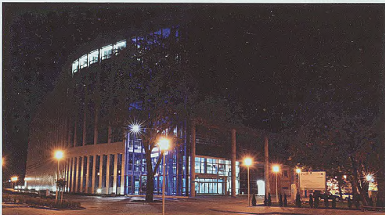
Oddane niedawno do użytkowania Centrum Nowych Technologii Politechniki Śląskiej po zmierzchu
