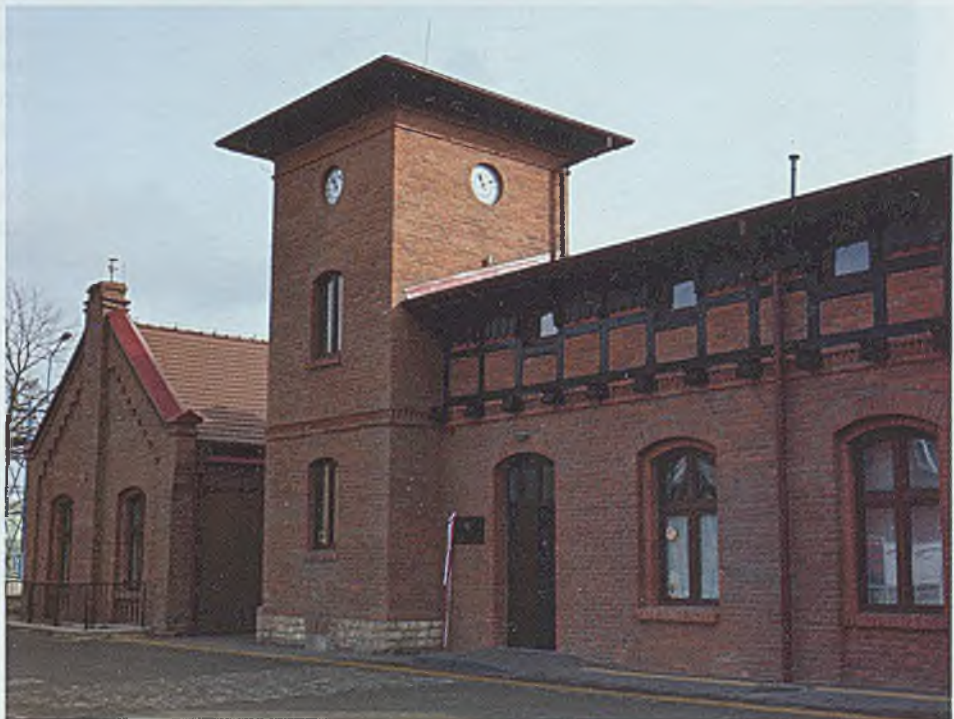
Centrum znajduje się w zabytkowym budynku dworca kolejowego w Radzionkowie
