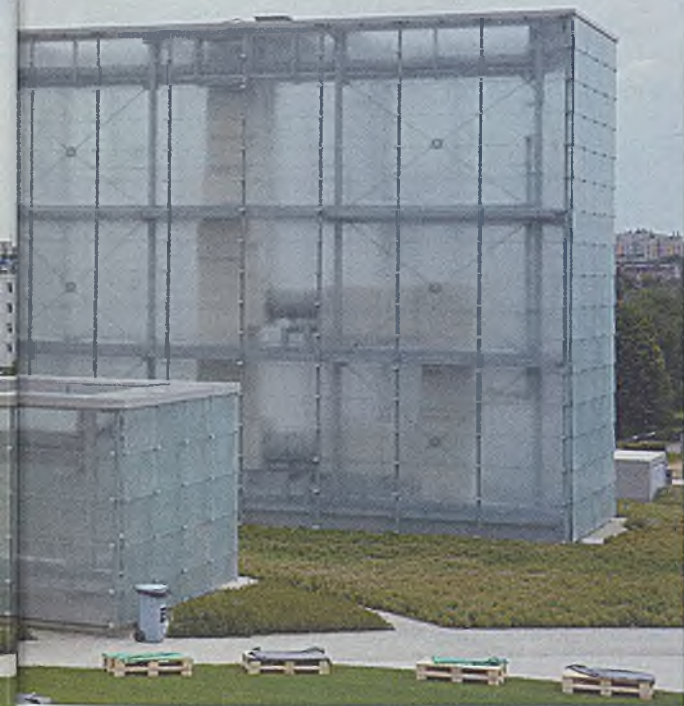
Sale wystawowe Muzeum Śląskiego znajdują się w podziemnej części budynku. Nad powierzchnią widać jedynie szklane konstrukcje doświetlające muzealne wnętrza
