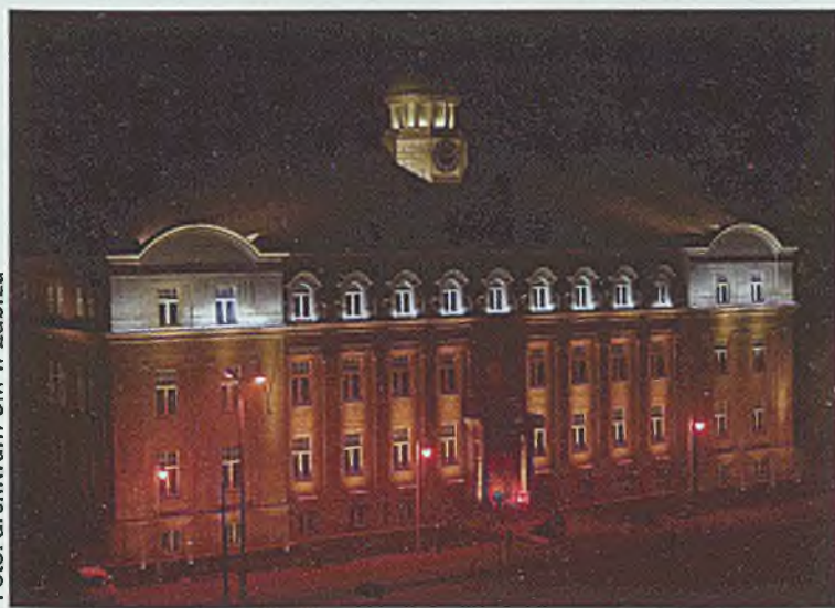
Budynek dawnej dyrekcji huty „Donnersmarck”, obecnie siedziba Urzędu Miejskiego w Zabrze
