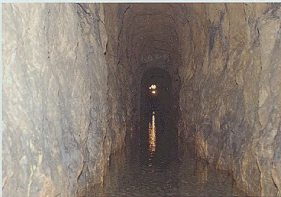
Sztolnia Czarnego Pstrąga to zabytkowy podziemny chodnik odwadniający, którego rolą było osuszanie pokładów kopalni „Fryderyk”
