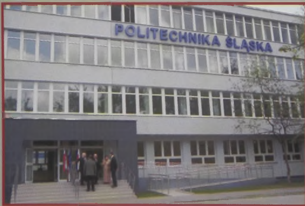
Odnowiona elewacja gmachu
