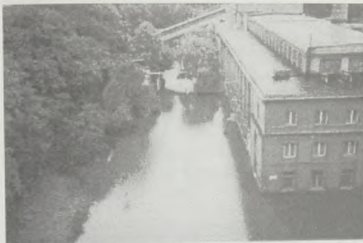
Widok na zatopiony budynek Hali Maszyn Ciepłych i Centralnej Ciepłowni
