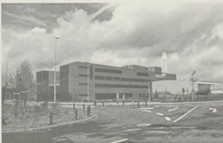
Spalarnia odpadów w Kolonii - najnowocześniejszy obiekt w Niemczech
