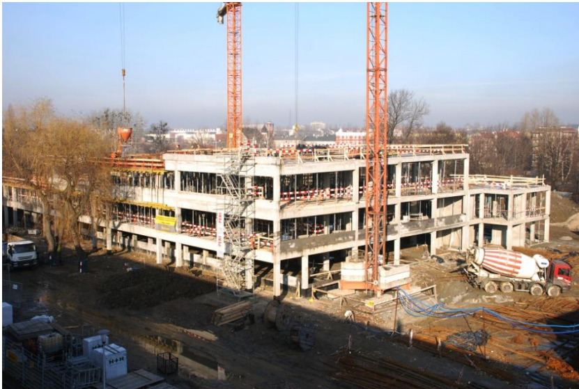
Budowa Naukowo- Dydaktycznego Centrum Nowych Technologii
