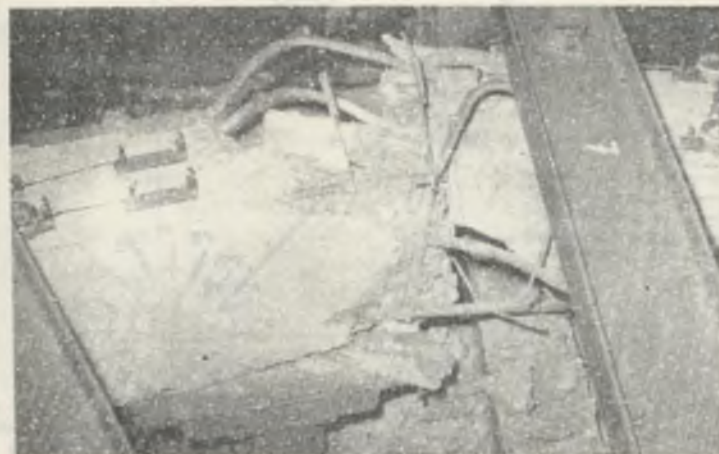
Rys. 8.12. Zerwane pręty wewnętrzne zbrojenia segmentu w pierścieniu obudowy (badanie nr 2, tablica 8.3)
