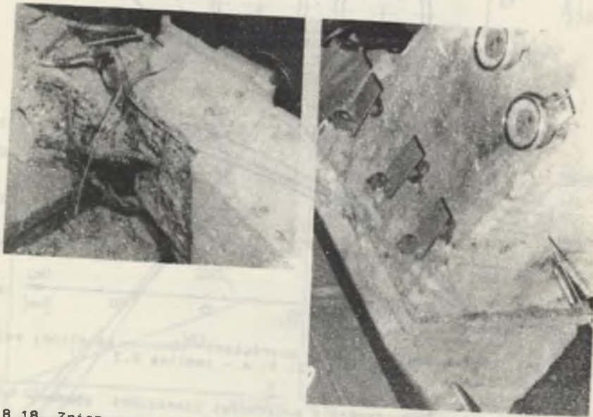
Pys. 8.18. Zniszczony segment przy siłowniku P11 i odkształcona wkładka pod siłownikiem P9 (rys. 8.19), po przekroczeniu granicznej wielkości obciążenia pierścienia obudowy (badanie nr 4 - tablica 8.3)
