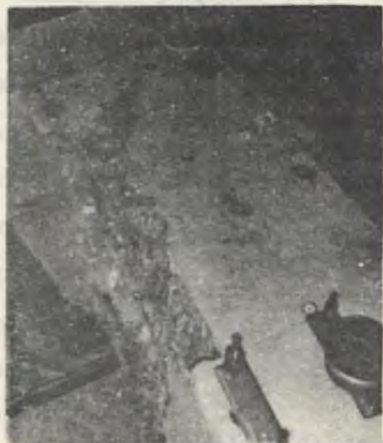
Rys. 8.22. Niszczenie przekroju pierścienia obudowy w niesymetrycznie obciążonym łuku pierścienia siłownikami P1, P2, P3 (rys. 8.24) wielkością p = 1,5 MPa (badanie nr 5 - tabl. 8.3)
