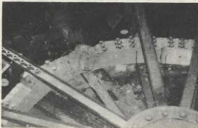
Rys. 8.31. Zniszczony segment (rys. 8.30) przy siłowniku P14 (rys. 8.33) po wywarceniu na badany pierścień obciążenia granicznego p = 2,2 \text{ MPa}
