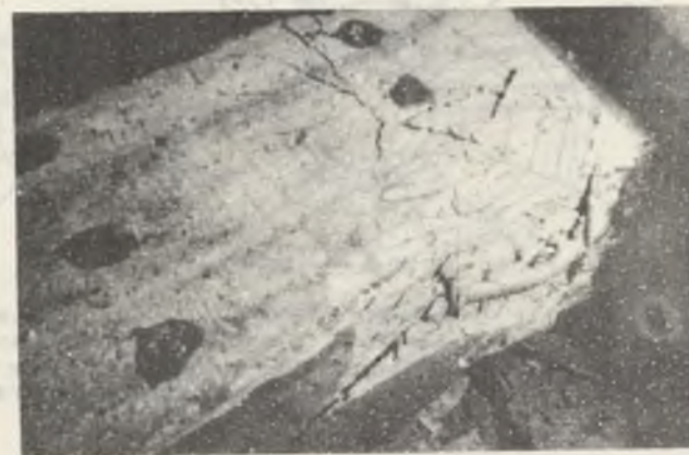
Rys. 39. Miążdżenie betonu w segmencie przy siłowniku P15 (rys. 41b) w aktywnie obciążonym pierścieniu trzema siłownikami z wypadkową na połączeniu dwóch segmentów p = 1,8 MPa (badanie nr 17 - tablica 8.3)
