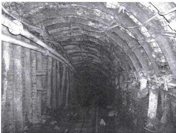
Fot. 6.1. Fragment chodnika podścianowego J-3 w pokł.707/1-2 na poz.1000 m w KWK „Anna” chronionego pasem podporowym o szerokości 1,5 m
