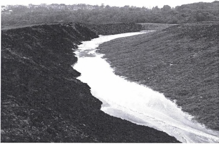
Rys. 4. Wykonanie nasypu rekultywacyjnego wraz z rowem izolacyjnym na składowisku „Skalny” (zdjęcie: Sebastian Piskała, w zbiorach Kopalni)
