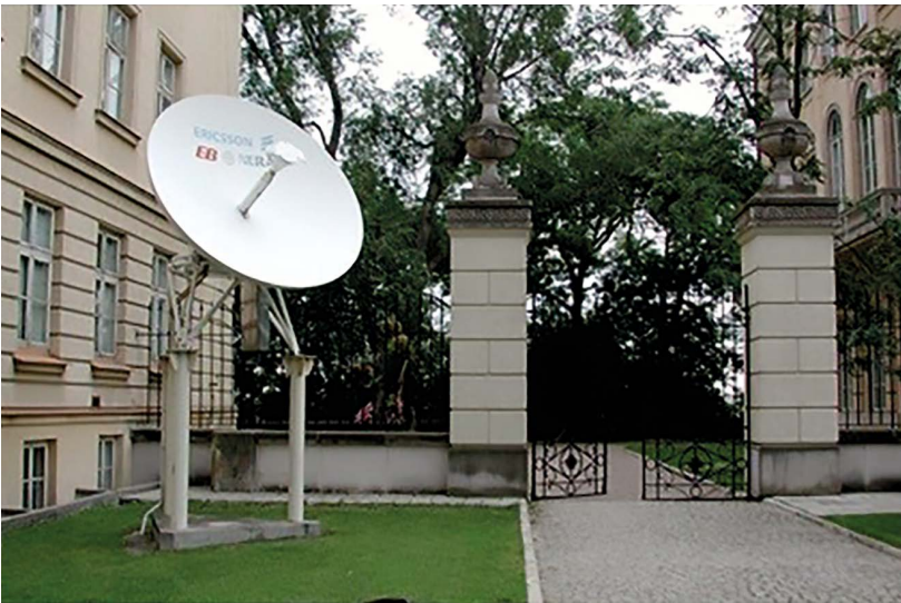
Fotografia 51. Antena satelitarna ustawiona w grudniu 1991 r. na dziedzińcu Uniwersytetu Warszawskiego. Przez ponad trzy lata stanowiła ona główne łącze polskiego Internetu ze światowym, obsługując linię satelitarną Warszawa–Sztokholm
