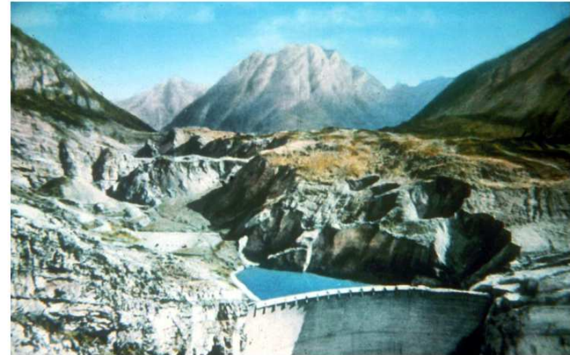
Zbiornik w Vajont po osunięciu się fragmentu góry Mount Toc. 100-metrowa fala przelewową pochłonęła 2500 ofiar miasteczka Longarone, Włochy. (Hoek, 2017)
