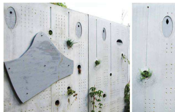
ryc. 4.7. Żywa ściana, autor: Exit Paysagistes Associés 25
