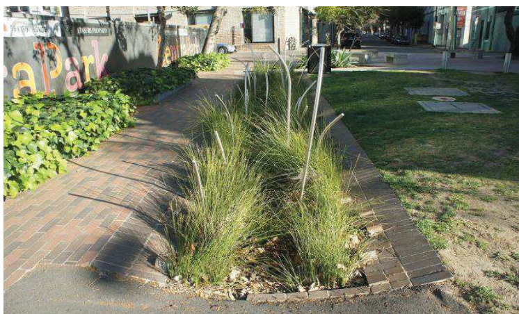
ryc.4.20. Kanały drenażowe z oświetleniem 37
