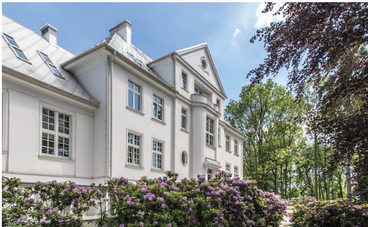
ryc.2.1. Siedziba Przedsiębiorstwem Wodociągów i Kanalizacji Spółka z o.o. w Gliwicach, ul. Rybnicka 27. Fot.: Krzysztof Krzemiński 3 .
