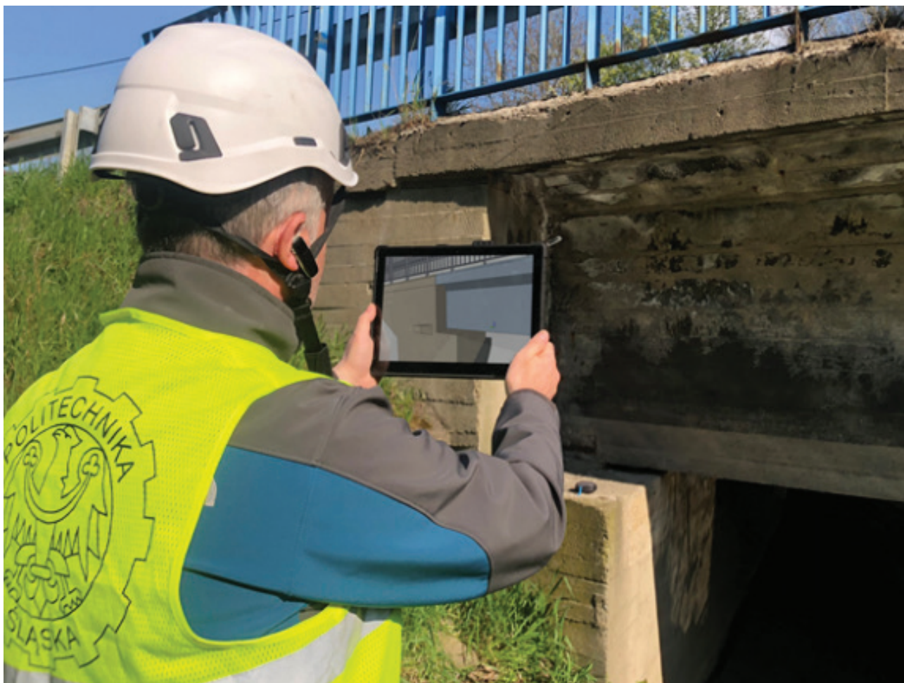
Inspekcja stanu technicznego mostu / fot. mat. konferencyjne
