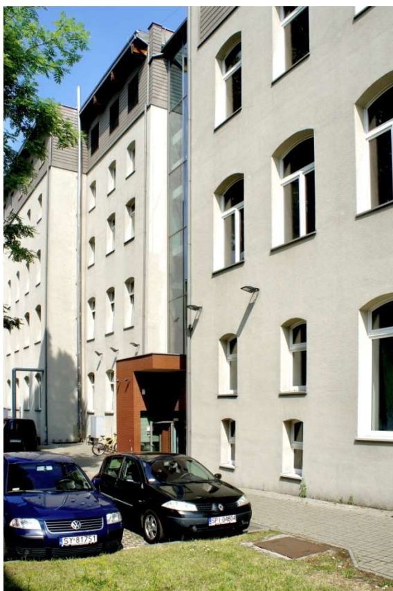
II. 91 Widok na wejście do PWST na tle szarej elewacji
