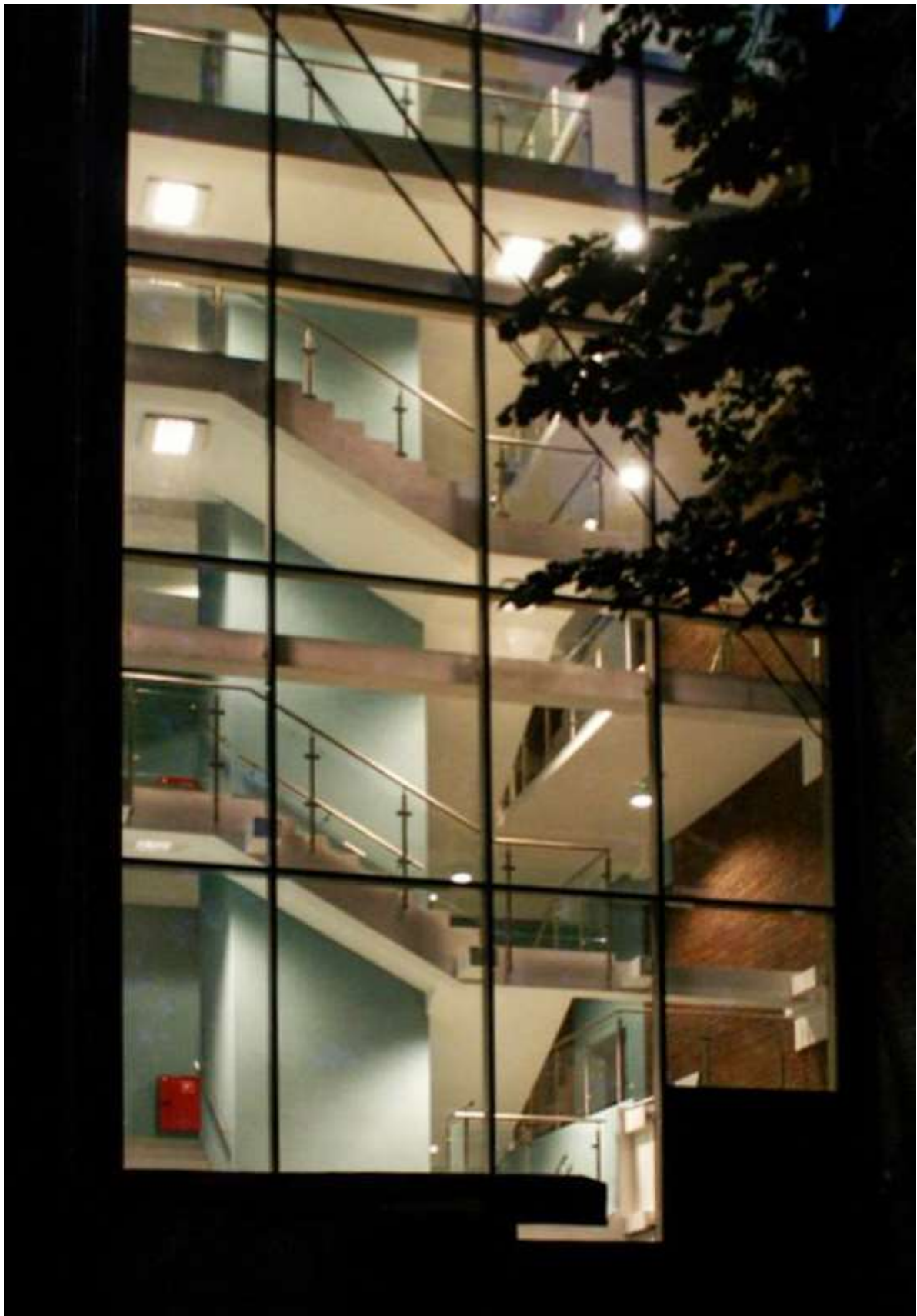
Il. 97 Nowoprojektowana przeszklona klatka schodowa. Autor fot. Daniel Płocica.
