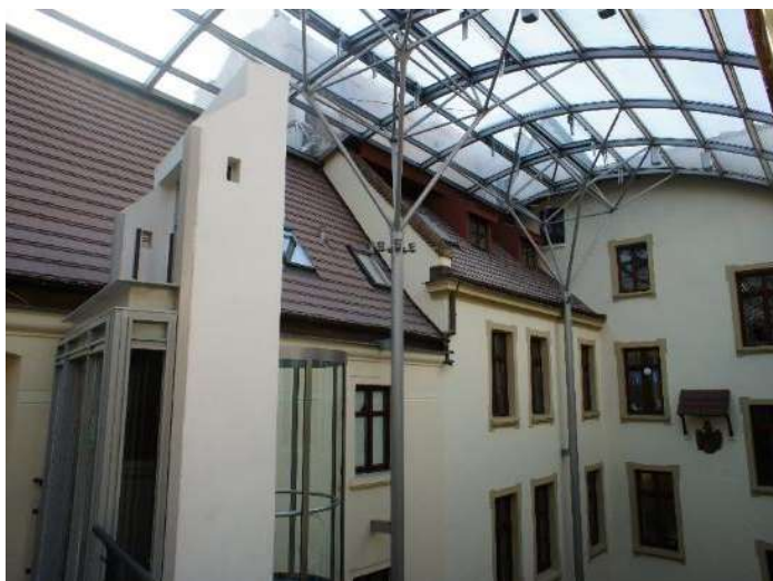
Il. 20 „Pasaż pod Błękitnym Słońcem”. Widok wnętrza. Autor fot. Daniel Płocica.
