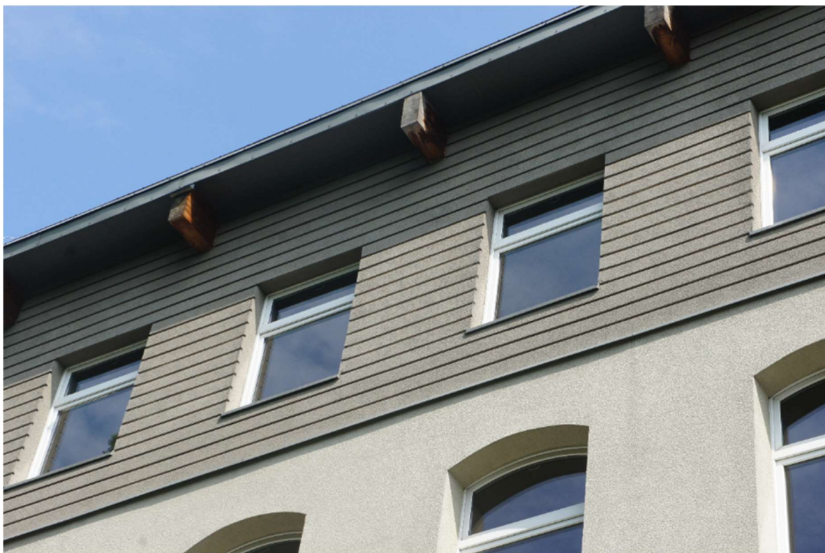
Il. 95 Elewacja PWST – szara powierzchnia elewacji. Autor fot. Daniel Płocica.
