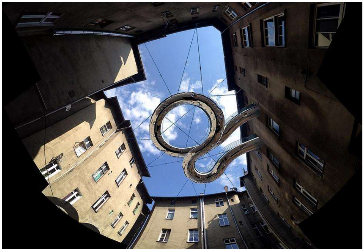
Il. 16 Widok na balkon z poziomu posadzki (źródło: http://www.zalewskiag.com/ )
