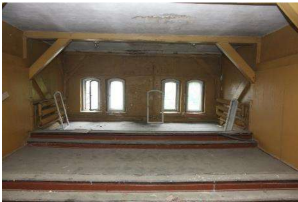
II. 84 ul. Piłsudskiego 24. Widok na wnętrze poddasza (2010) Autor fot. Daniel Płocica.
