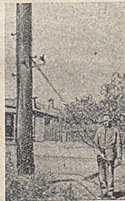
Rys. 3. Wykrywanie stałych upływów prądu przez wbięcie górnego kolka przyrządu w słup.
