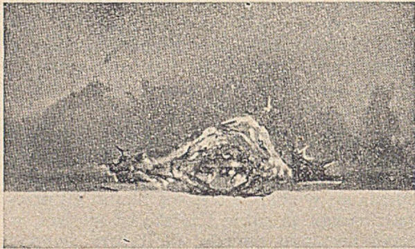
Rys. 8. Pręt uzwojenia maszyny elektrycznej uszkodzony wskutek zwarcia z ziemią
