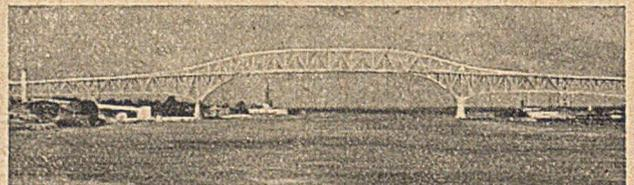
Abb. 3. Durchlaufender Fachwerkbalken über den St. Clair River bei Port Huron, Michigan. (Mittelöffnung 287 m).
