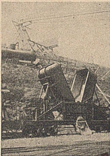
Abb. 11. Doppelkipwagen zum Betontransport (Hiwassee-Staumauer).
