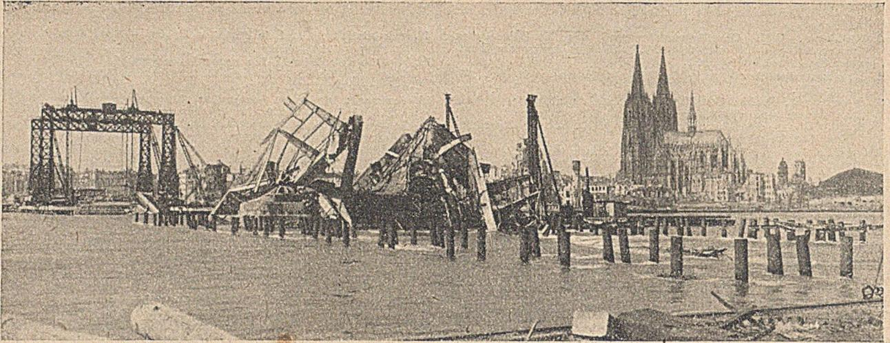
Abb. 3. Baustelle mit den gerammten Röhren für die Verschubbahn der Hubportale bei Hochwasser (am 26. 3. 1947).
