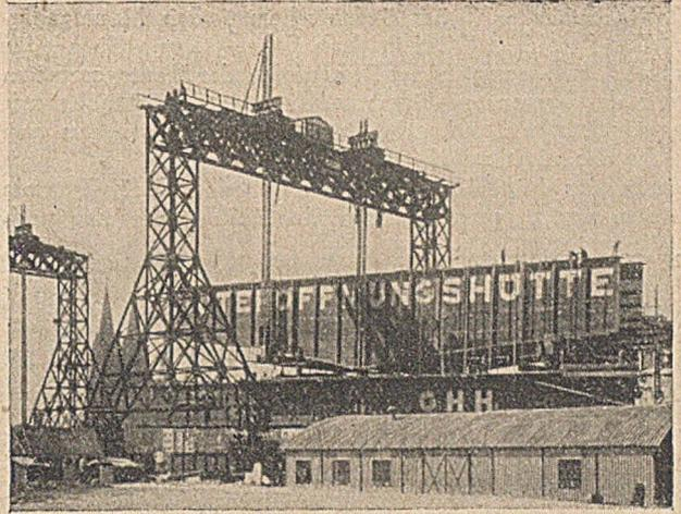
Abb. 8. Zusammenbau des Pfeilerstückes auf dem rechten Montageplatz (am 28. 4. 1948).
