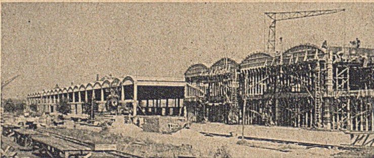
Abb. 15. Kaischuppen 75 am Kronprinzkai im Bau, Ansicht von der Landseite.
