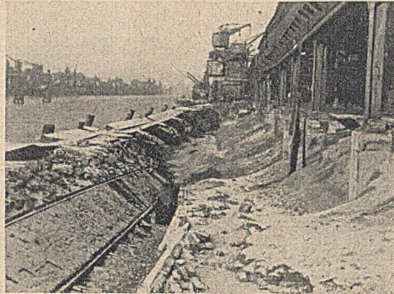
Abb. 1a und b. Zerstörte Kaimauer am Australiakai. — Rutschung des Geländesprungs auf einer gekrümmten Gleitfläche (Fall 1).
