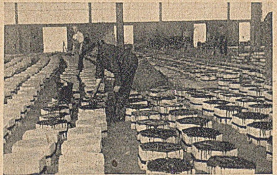
Abb. 16. Betonsteinpflaster am Kaischuppen 75. — Aufbringen des Oberflächenanstrichs.
