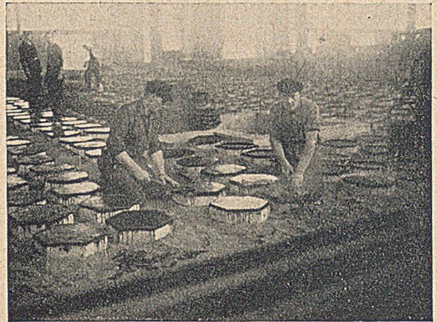
Abb. 3. Sechseckplatten. Aufbringen des Heißasphaltanstriches.
