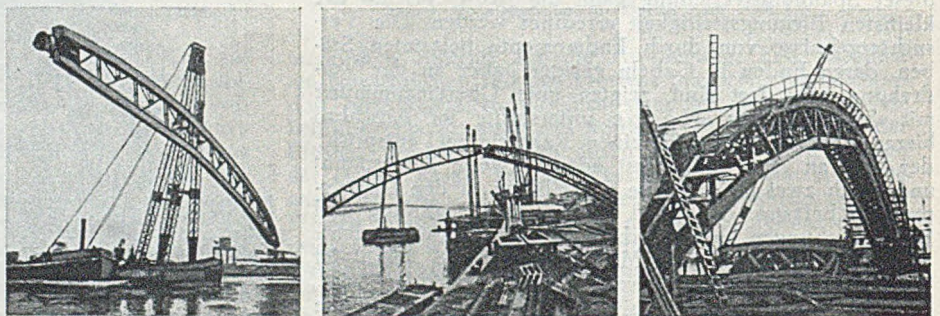
Abb. 5. Viadukt von Renory. Verschiedene Bauzustände der Montage des zweiten Lehrgerüsts.
