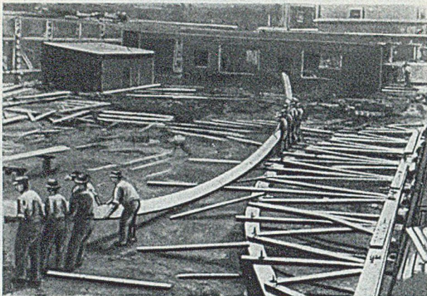
Abb. 5. Zusammenbau eines Fachwerkbinders mit gekrümmtem Lamellenobergurt.
