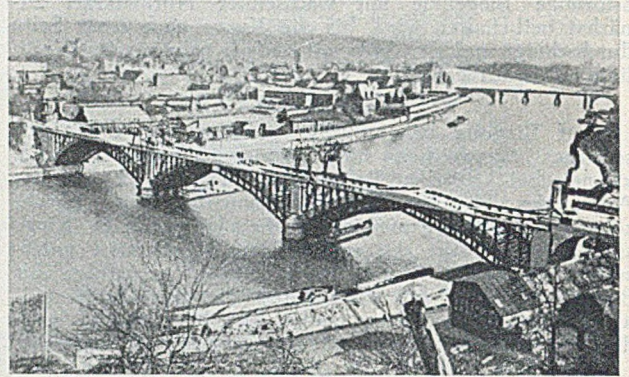
Abb. 6. Lehrgerüst der Maasbrücke bei Huy.
