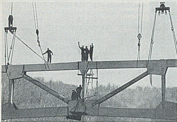
Abb. 2. Einsetzen des Hauptträger-Mittelstückes.
