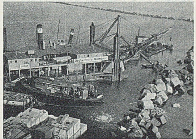
Abb. 1. Schwimmlöffelbagger beim Aufräumen von Molentrümmern.
