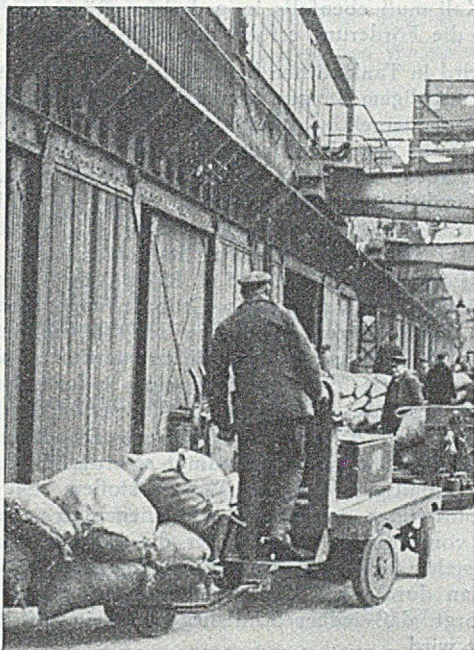
Abb. 10. Elektrokarrenverkehr auf der wasserseitigen Rampe.
