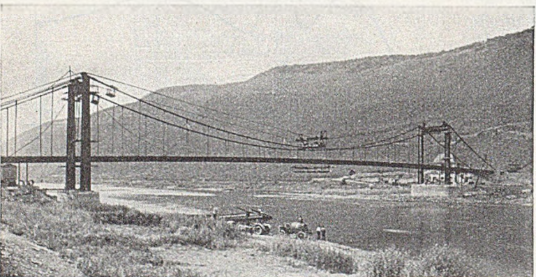
Abb. 26. Kurz vor der Fertigstellung.
