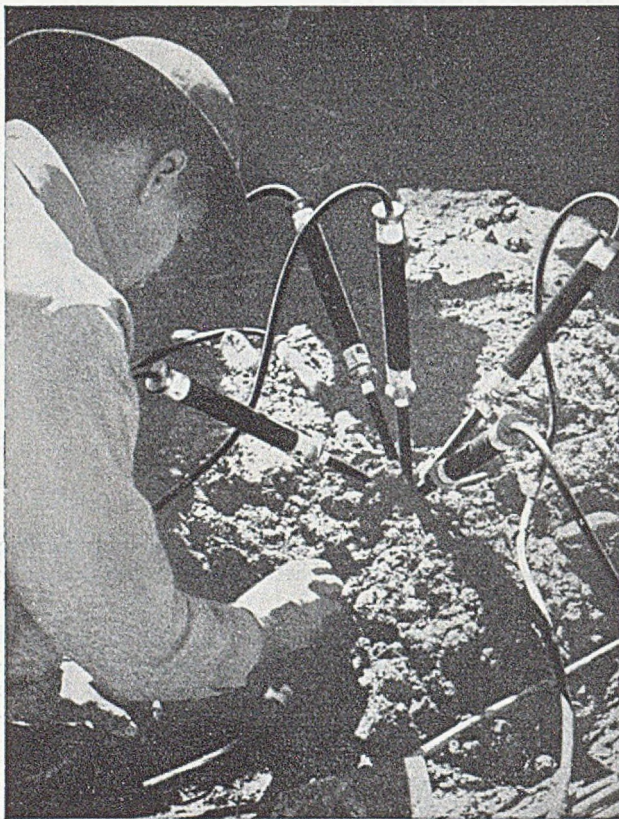
Abb. 4. Einbau von Spannungsmessern in den Beton der Shasta-Staumauer.
