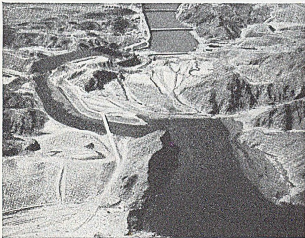
Abb. 1. Coloradostrom-Umlenkung für den Bau der Davis-Talsperre.
