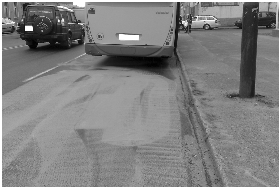
Rys. 3.3. Sorpcja substancji w warunkach stabilności pogodowej na otwartej przestrzeni sorbentami pochodzenia nieorganicznego mineralnego.
