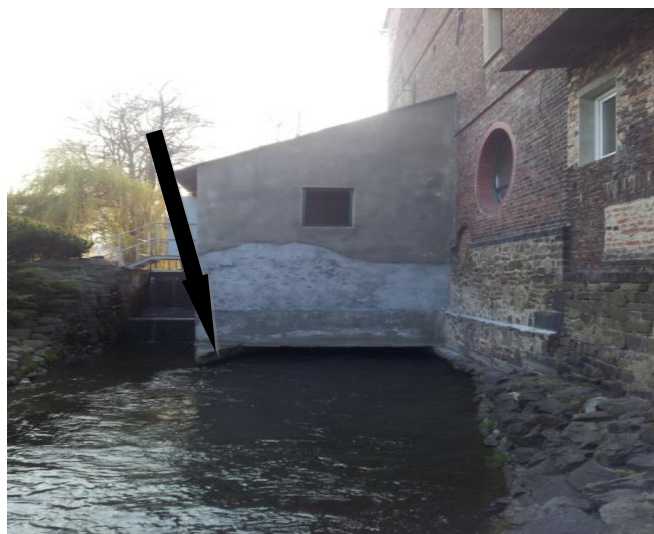
Rys. 5.1.3 Dolna woda elektrowni
