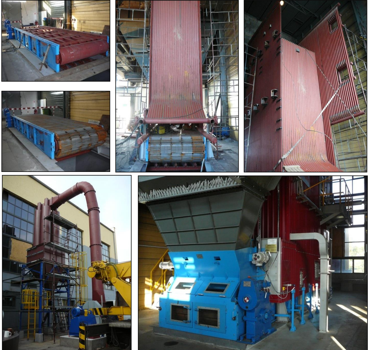
Rys. 3.1 Postęp prac przy modernizacji kotła K4-WR-10-012 [2]
