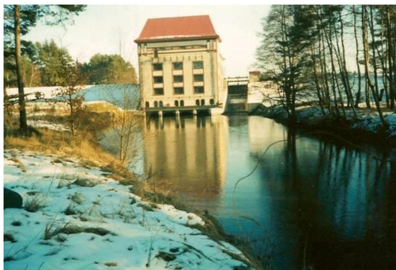
Rys. 5 Widok na elektrownię wodną „Niedalino” od strony wylotowej (Radew)
