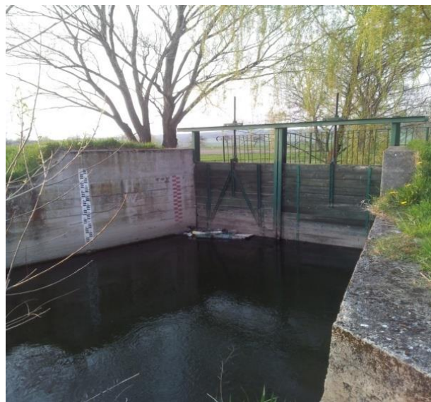
Rys. 5.1.6 Widok śluzy w wale przeciwpowodziowym
