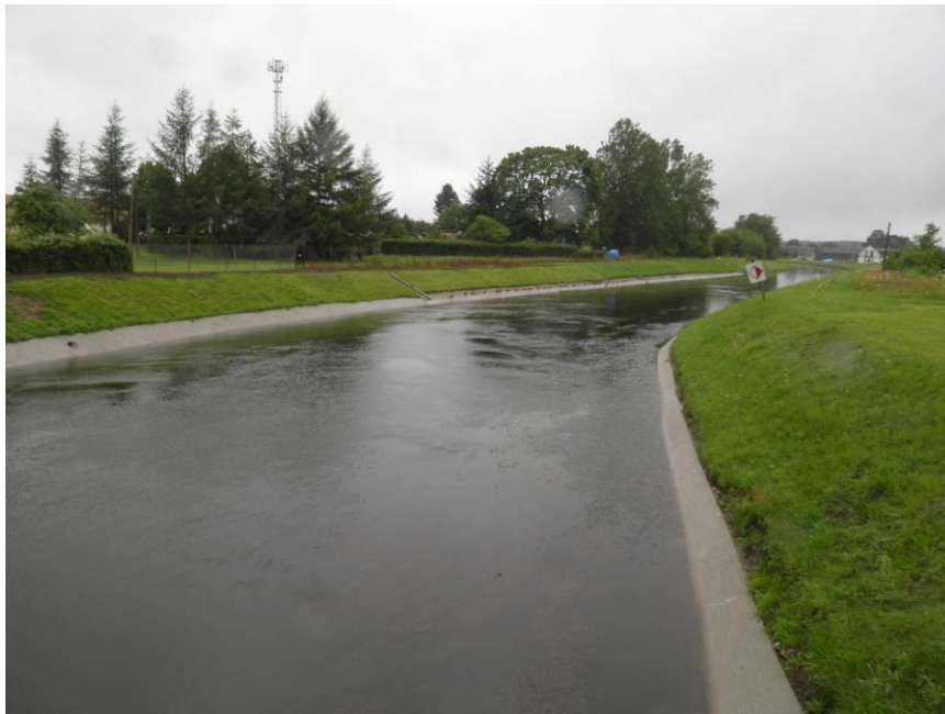
Rys. 6 Kanał derywacyjny (Rosnowski) doprowadzający wodę do elektrowni Rosnowo
