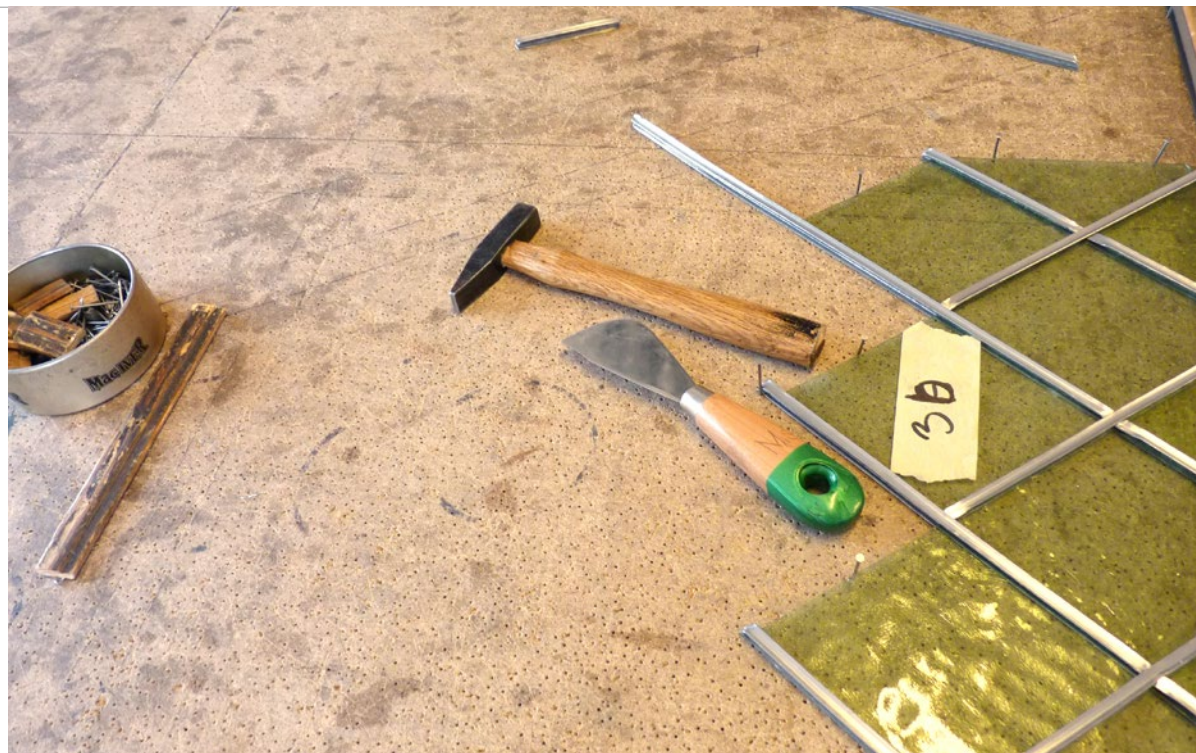
Ryc. 69. Montaż szkła w profile ołowiane
