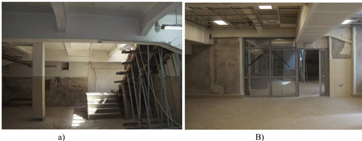
Rys. 6.6. Przebudowa Laboratorium Powłok Ochronnych i Obróbki Ciepłej – a), b)
