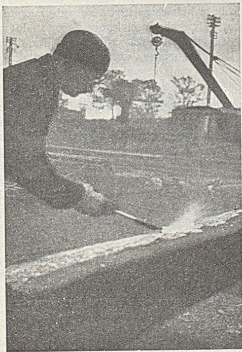
Rys. 44. Usuwanie wadliwych miejsc na wlewie za pomocą palnika.
