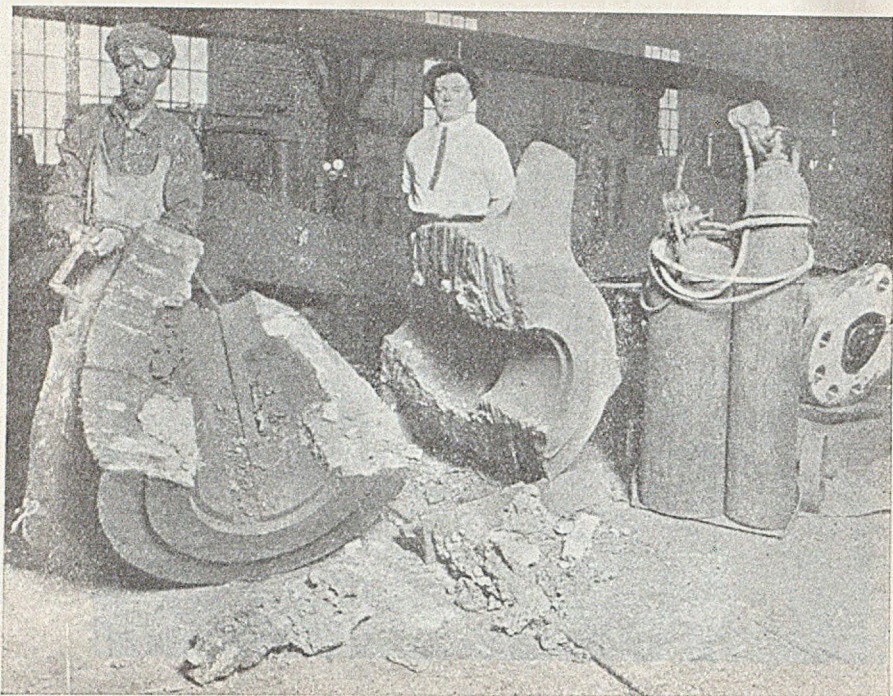
Rys. 136. Cięcie palnikiem piasty żelaznej wirnika turbiny wodnej.
