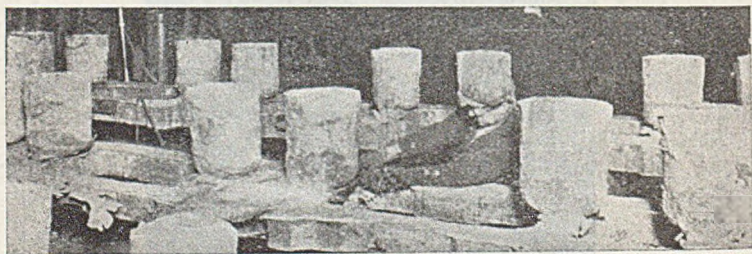
Rys. 40. Odcinanie nadlewek palnikiem na ramie parowozowej.
