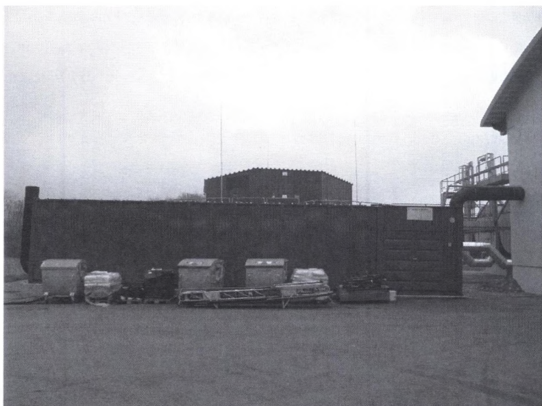
Fig. 2. Biofiltr - Bioplynová stanice Amstetten GmbH (Rakousko)
