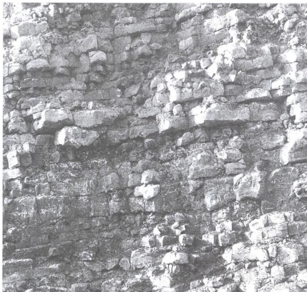
Rys. 2. Odślonięta ściana hałdy żuźla szybowego
