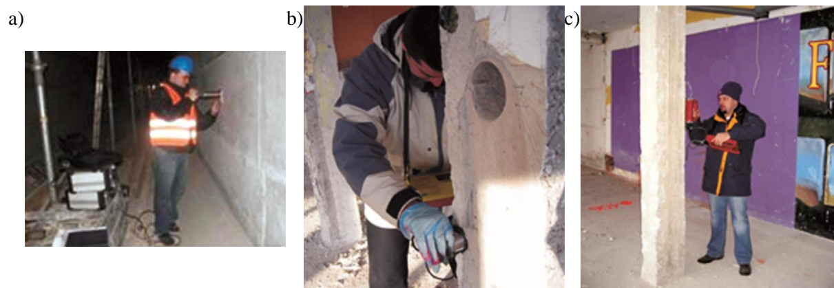
Fot. 3.10. Badania nieniszczące: a) lokalizacji wad struktury betonu urządzeniem DOCTer Impact-Echo (na fotografii dr inż. Adam Piekarczyk w 2009 roku, fot. R. Jasiński), b) badania prędkości fali ultradźwiękowej urządzeniem PunditLab (na fotografii dr inż. Radosław Jasiński w 2008 roku, fot. Ł. Drobiec), c) badania położenia zbrojenia urządzeniem FS 100 (na fotografii dr inż. Łukasz Drobiec w 2008 roku, fot. R. Jasiński)
