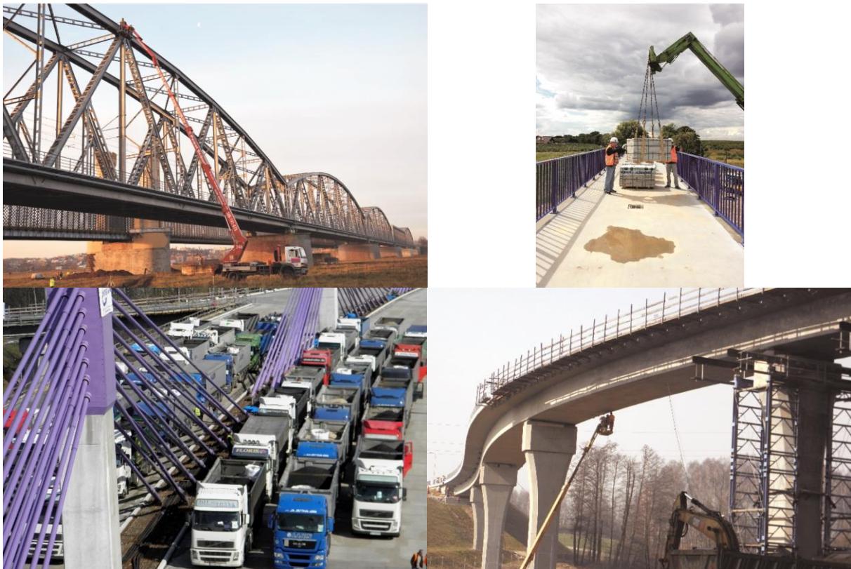
Fot. 6.13. Przykłady pokazujące prace in situ prowadzone przez mostowców Photo 6.13. Examples showing in situ work carried out by bridges
