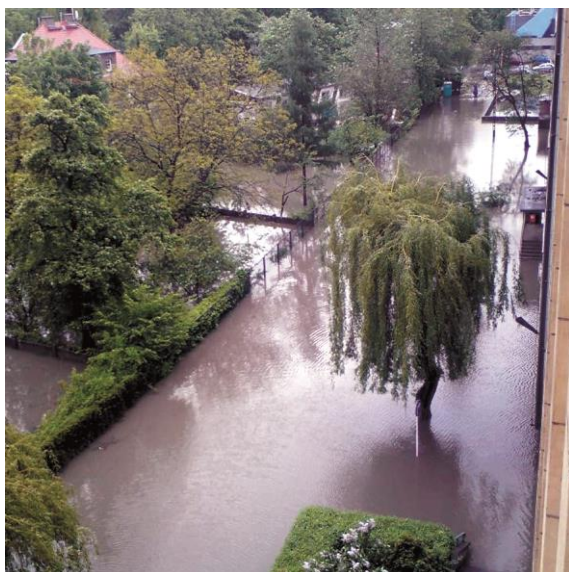
Fot. 3.5. Otoczenie budynku Laboratorium Budownictwa w trakcie przejścia kulminacyjnej fali powodzi (18.05.2010 r.). Z lewej strony widoczny dach willi przy ul. Kaszubskiej 22, z prawej strony widoczny niebieski dach Hali Sportowej (fot. D. Drynda)
