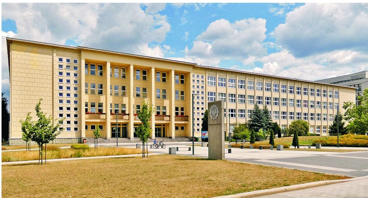
Fot. 1.1. Wydział Budownictwa 2019 r. (fot: W. Miros) Photo 1.1. Faculty of Civil Engineering 2019 (Photo W. Miros)
