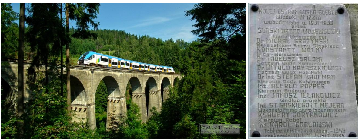
Rys. 2.39. Most w Wisła Łabajowie październik 2012 (zbiór: Marcin Gola) i tablica pamiątkowa
