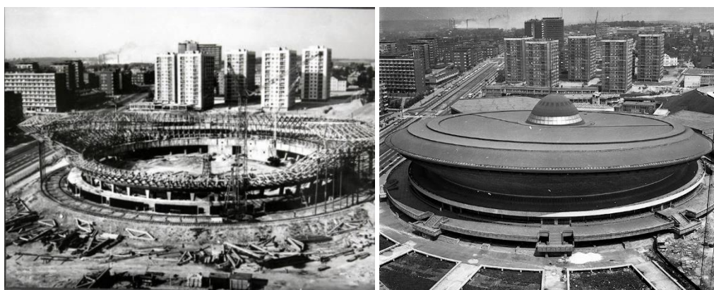
Rys. 2.83. Katowicki Spodek w fazie budowy i po oddaniu do użytku w 1972 roku
