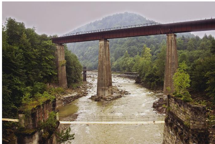
cd. rys. 2.26. Most przez rzekę Prut pod Jaremczem: c) stan po odbudowie po II wojnie światowej 38 cont. fig. 2.26. Bridge over the Prut River near Jaremcze: c) condition after reconstruction after World War II 38
