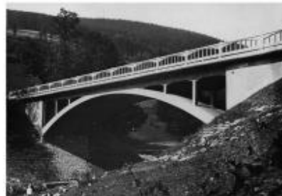
Fig. 2. Most łukowy żelbetonowy rozpiętość 27 m na przebieżonej drodze wojewódzkiej Żywiec — Kęty. Projekt autora artykułu.
