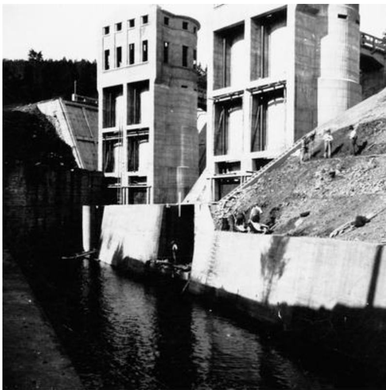
Rys. 2.54. Widok sztolni z wieżami zasuw zapory w Porąbce (zbiór: Narodowe Archiwum Cyfrowe) Fig. 2.54. View of the adit with gate valve towers in Porąbka (collection: National Digital Archives)
