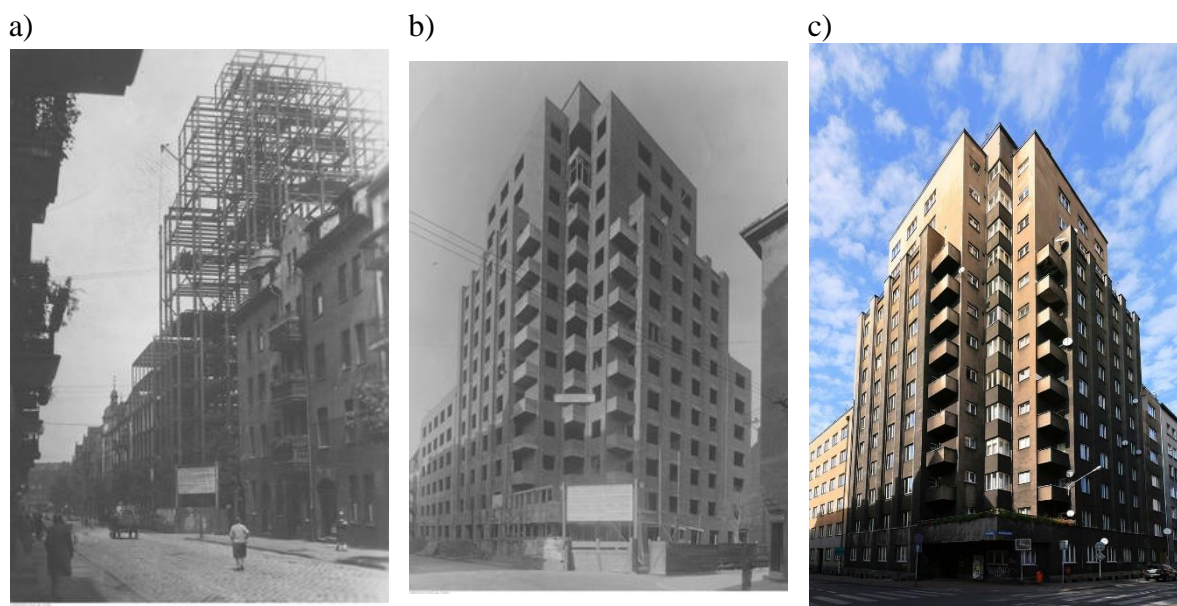
Rys. 2.37. Gmach urzędów skarbowych w Katowicach: a) w czasie budowy, b) widok z listopada 1931 roku, c) stan obecny (zbiór: Narodowe Archiwum Cyfrowe)
