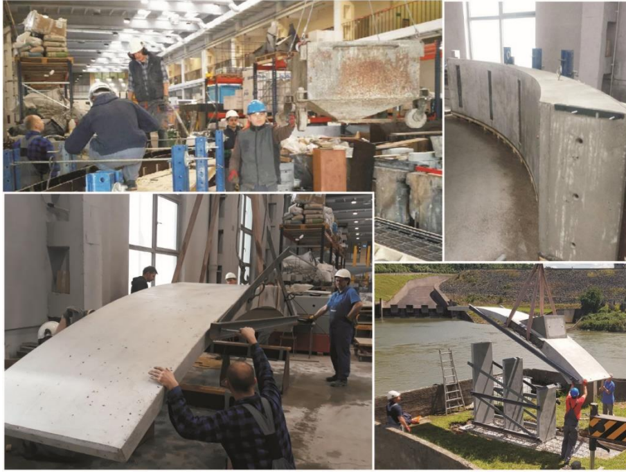
Rys. 2.102. Zespół pracowników Laboratorium Budownictwa Politechniki Śląskiej podczas wykonywania i montażu monumentu (luty–lipiec 2020 roku). Od lewej strony zwrócenie w kierunku obiektywu: Karol Konopka (z boku), Grzegorz Cygan, Bartłomiej Pudełko, Tomasz Hahn, Wojciech Szczeciński (z boku), Krzysztof Jonderko
