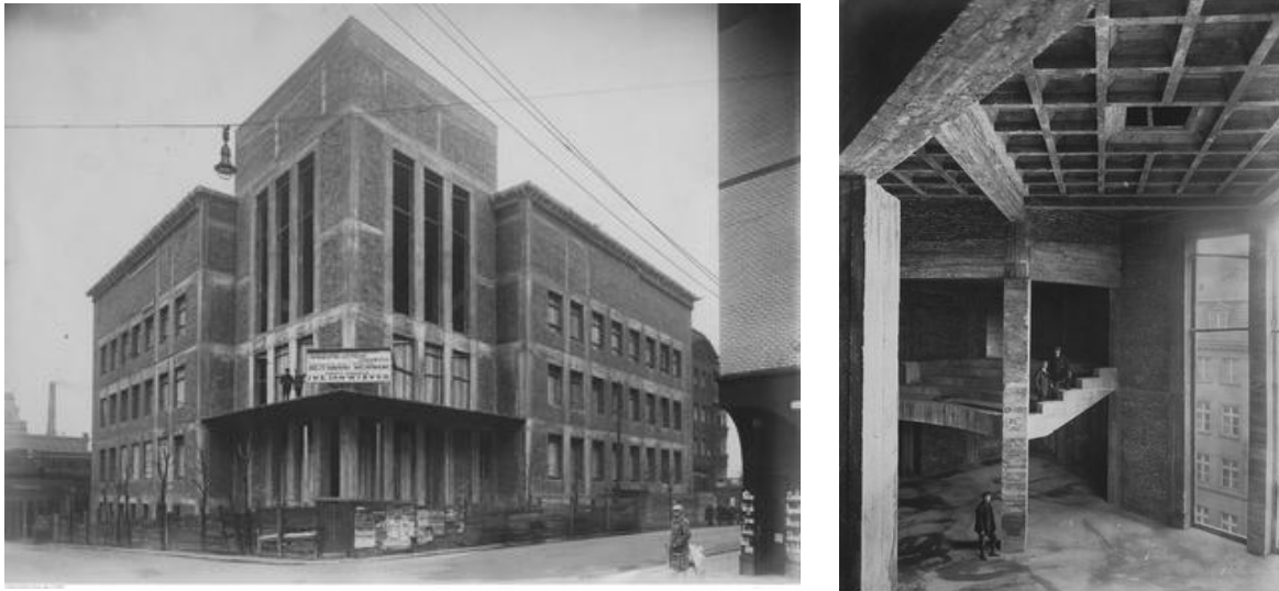
Rys. 2.38. Dom Oświatowy Towarzystwa Czytelni Ludowych z Biblioteką Śląską w trakcie budowy w 1930 roku (zbiór: Narodowe Archiwum Cyfrowe)
