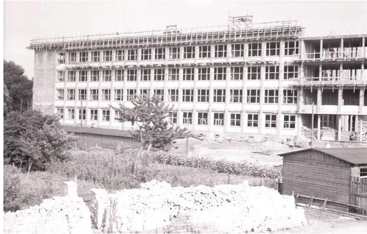
Rys. 5.4. Końcowa faza budowy skrzydła zachodniego Wydziału Inżynieryjno-Budowlanego w 1951/52 roku (widok od strony obecnej ulicy Akademickiej) (zbiór: Archiwum Politechniki Śląskiej)
