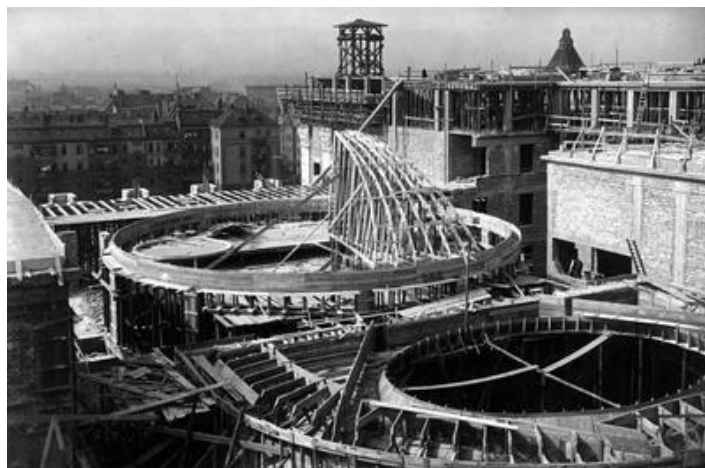
Rys. 2.35. Budowa gmachu Sejmu Śląskiego i Urzędu Wojewódzkiego w Katowicach wrzesień 1926 rok. (zbiór: Narodowe Archiwum Cyfrowe)
