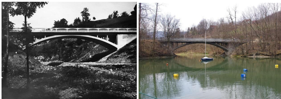
Rys. 2.53. Żelbetowy most łukowy (o rozpiętości 27 m) nad Wielką Żarnówką w ciągu drogi Żywiec – Kęty w 1936 i 2017 roku. (zbiór: Narodowe Archiwum Cyfrowe / Andrzej Mokrosz)
