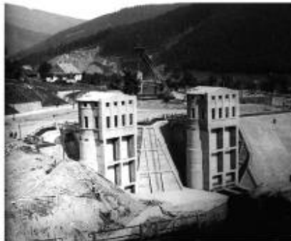
Fig. 1. Wieże zasuw przegrody doliny w Międzybrodziu Porąbce. Wysokość wież, licząc od stopy fundamentu, około 33 m, z czego tylko 10 m będzie wystawać ponad najwyższe zwierciadło wody przyszłego zbiornika. Projekt konstrukcyjny żelbetonowych wykonał autor artykułu.
