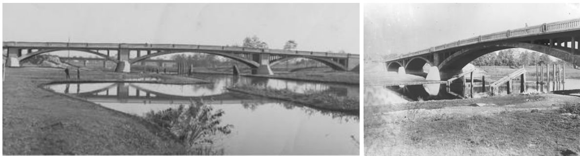
Rys. 2.33. Żelbetowy most łukowy na Wiśle pod Bieruniem Nowym w październiku 1930 roku (zbiór: Narodowe Archiwum Cyfrowe)
