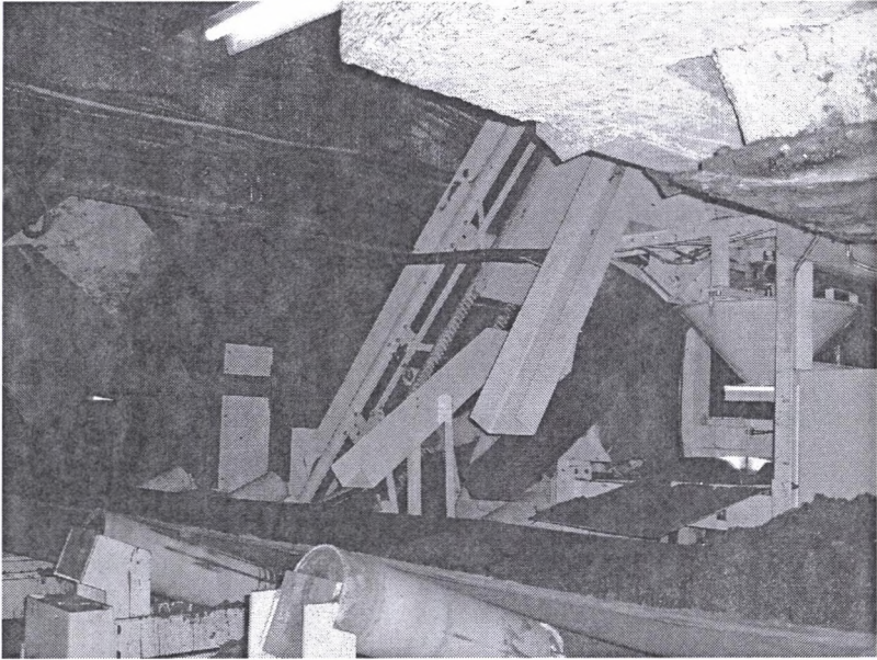
Rys. 1. Widok prototypu urządzenia zainstalowanego w KWK Bolesław Śmiały Fig. 1. View of a prototype device installed at the Boleslaw Smialy Coal Mine
