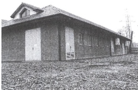
Rys. 11. Budynek rozdzielni Fig. 11. The dispatch and switching station
