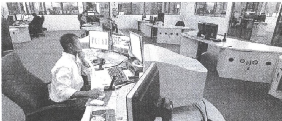
Fot. 3. Centrum dyspozytorskie na powierzchni: wszystkie operacje pod ziemią i w zakładzie przeróbki są kontrolowane i sterowane przez to Centrum [2]
