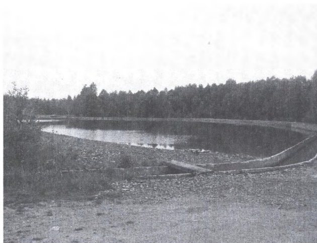
Fot. 1. Odtworzona komora „B” Photo 1. Regenerated chamber „B”
