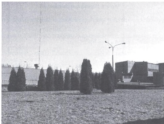
Fot. 3. Stacja uzdatniania wody – widok ogólny Photo 3. Water purification plant – general view
