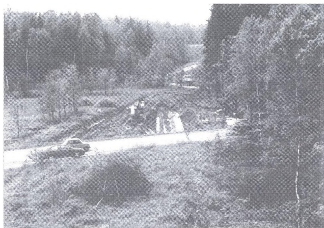
Fot. 18. Rejon przepustu drogowego potoku Bolina Południowa Photo 18. Road passage in the area of South Bolina stream
