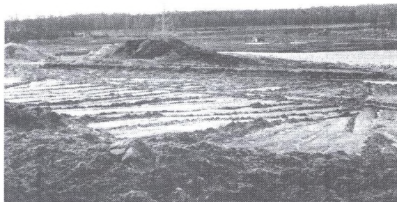
Fot. 14. Rekultywacja terenu przez likwidację zalewiska przy ulicy Spacerowej Photo 14. Land reclamation through liquidation of overflow land at Spacerowa street
