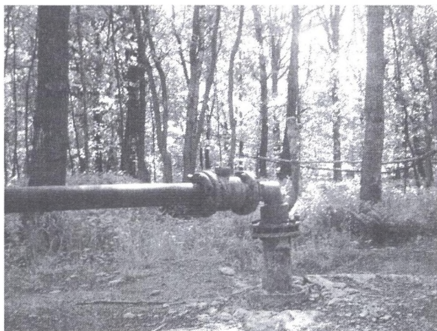
Fot. 6. Otwór wiertniczy do zatłaczania mułów do płytkich zrobów Photo 6. Borehole for compression of silts into shallow cavities caused by the extraction
