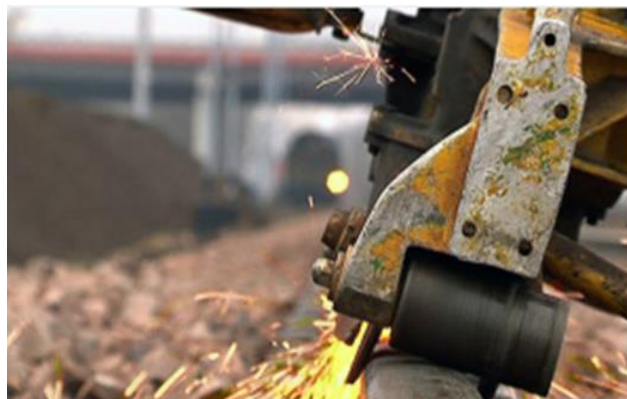
Rys. 26 Szlifowanie szyn [139].
