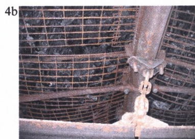
Fot. 3a; 4a. Strefy z podwyższoną temperaturą i wypływającym CO w stropie wyrobiska Fot. 3b; 4b. Ocios wyrobiska w obudowie ŁP z wykładką stalową
