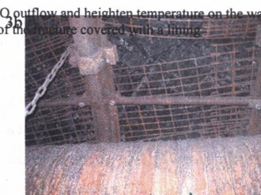
Fot. 1a; 2a. Lokalizacja szczeliny z wypływem CO i podwyższoną temperaturą w ociosie wyrobiska Fot. 1b; 2b. Ocios wyrobiska w strefie szczeliny zasłoniętej wykładką
