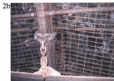
Fot. 1a; 2a. Lokalizacja szczeliny z wypływem CO i podwyższoną temperaturą w ociosie wyrobiska Fot. 1b; 2b. Ocios wyrobiska w strefie szczeliny zasłoniętej wykładką
