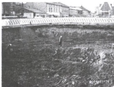
Rys. 3.5. Wkop pod budowlę z częściowo wylanym fundamentem
