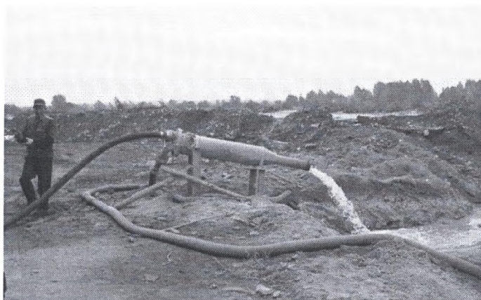
Rys. 6. Wykonywanie mieszaniny wodno-popiołowej przez zmywanie pyłu Fig. 6. Water-ash preparing on ash rinsing
