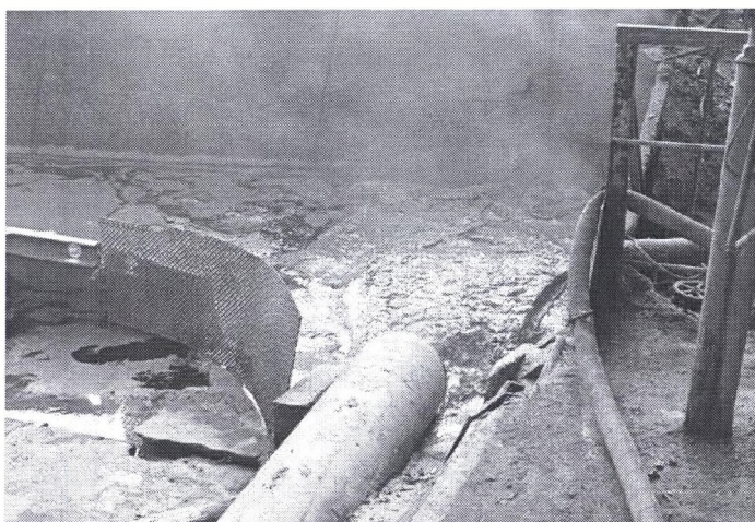
Rys. 5. Wykonywanie mieszanki wodno-popiołowej przez zmywanie pyłu
