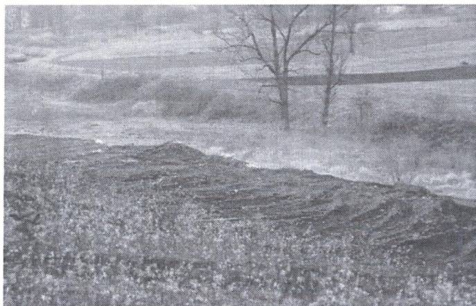
Rys. 9. Rów chłonny na Hałdzie Ruda przykryty materiałem z wykopu, widoczne dymy świadczą o rozwoju pożaru na rowie
