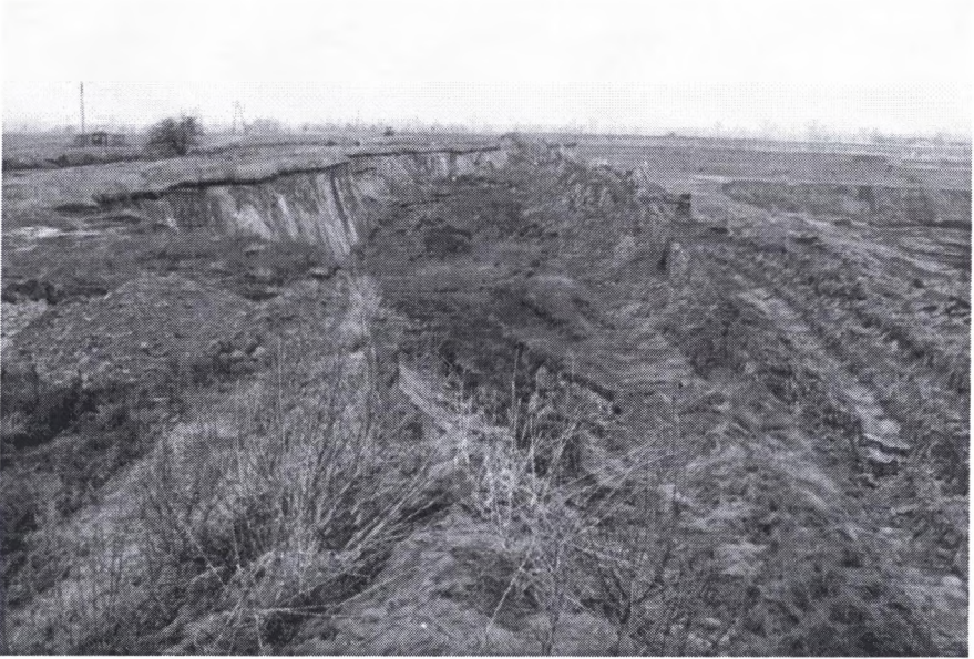
Fot. 3. Osuwisko na zboczu stałym odkrywki w KWB Konin Phot. 3. Landslide at permanent slope of Konin surface mine
