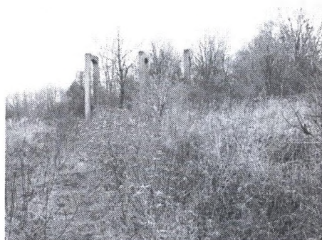
Rys. 8. Pozostałości żelbetowej konstrukcji (fot. W. Preidl)
