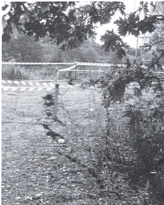
Fot. 3. Przykład przerwania ciągłości terenu (szczelina) Photo. 3. Break of ground surface continuity (gap)
